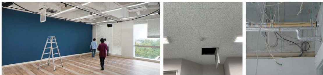
図 16. 工事中の記録。抜け感のある天井高。右 2 枚は取り外した従来の天井パネルと、むき出しの天井配管。
