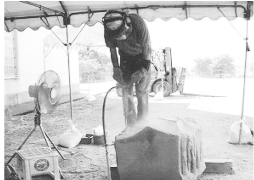
ルートハンマー（小型削岩機）による穴あけ
